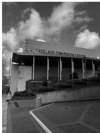
② アデレードコンベンションセンター
